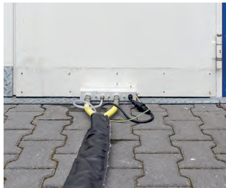
Auch für die Installation unter Feuerschutztüren ist PlanoPT einsetzbar – optimal zur Klimatisierung etwa von Hallen.
