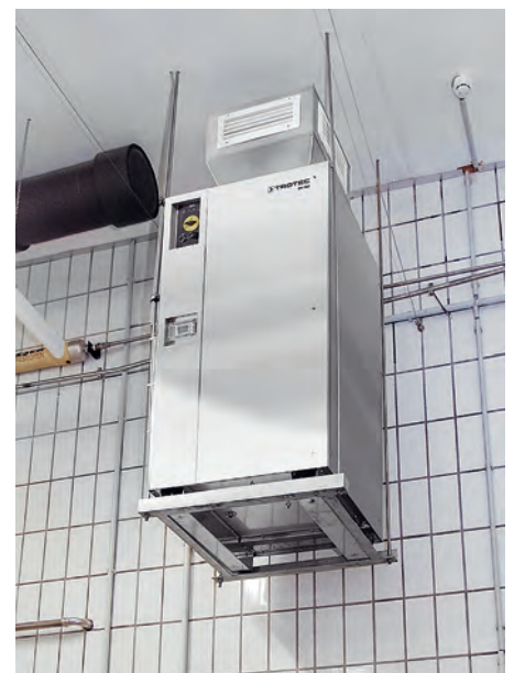
Die größeren Standgeräte der DH-Serie verfügen ausblasseitig über einen Rechteck-Kanalanschluss zur einfachen Integration in bestehende Lüftungssysteme. Darüber sind optional Lüfterschläuche anschließbar und auch individuelle Sonderbauten, zum Beispiel Lüftungshauben, auf Anfrage realisierbar.
