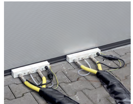
Ebenso lassen sich Rolltore zur Installation der Verbindungssets mittels ein oder mehrerer PlanoPT verwenden. Die Rolltore können dabei ganz normal geschlossen werden.
